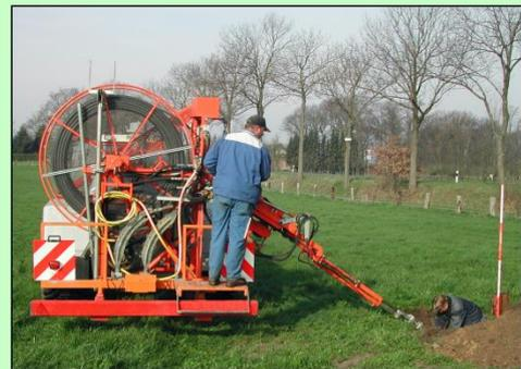
Kontroll-, Wartungs- und Instandsetzungsarbeiten (Dränaufgrabung bzw. Dränspülung) hilfreich.
